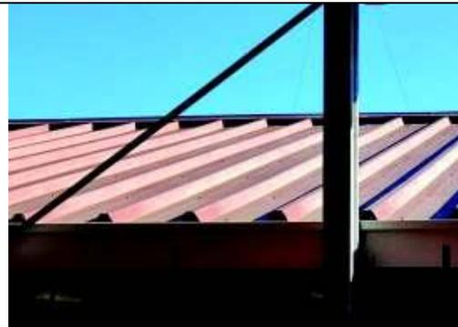
Foto N° 48: Materialidad de las planchas instaladas en la cubierta son del tipo PV-4.
