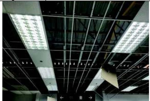
Foto N° 4: Cielo falso instalado completamente dañado.
