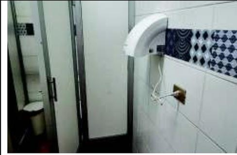
Foto N° 39: Baño profesoras, línea cerámica de colores reemplazada por banda adhesiva.
