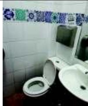
Foto N° 40: Baño personal servicio, línea cerámica de colores reemplazada por banda adhesiva.
