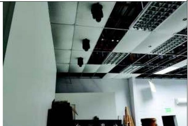
Foto N° 6: Cielo falso instalado completamente dañado.
