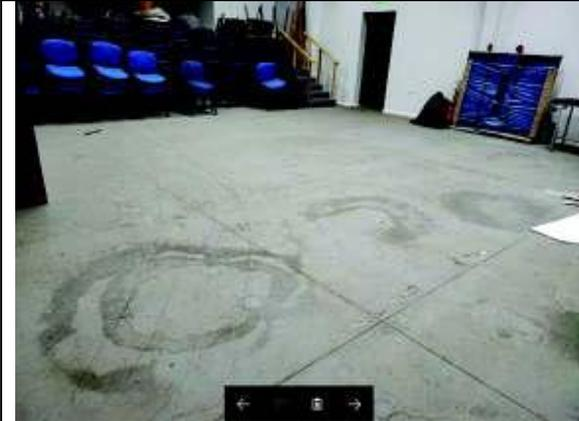
Foto N° 7: Marcas en el piso que evidencian filtraciones de agua lluvia a través de la cubierta.
