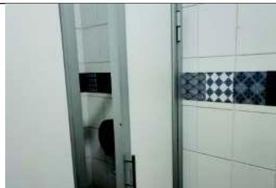
Foto N° 37: Baño profesores, línea cerámica de colores reemplazada por banda adhesivo.
