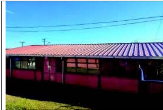
Foto N° 47: Materialidad de las planchas instaladas en la cubierta son del tipo PV-4.
