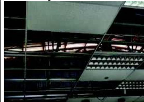
Foto N° 9: Alero descubierto permite el ingreso de viento y agua lluvia al interior del recinto.
