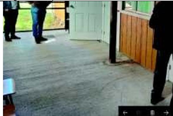
Foto N° 3: Pasillo de acceso a sala de integración presenta ondulaciones en la superficie.
