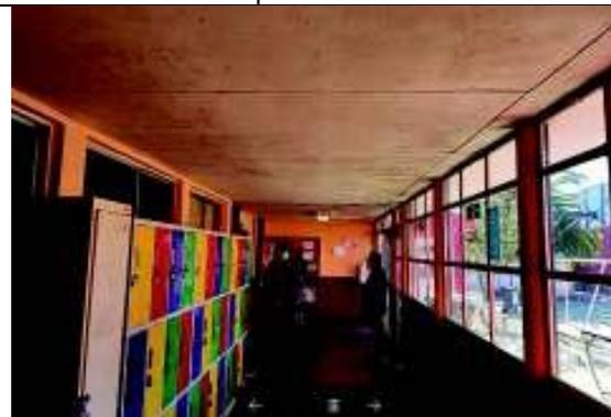
Foto N° 29: Falta de pintura en cielo del hall de acceso.
